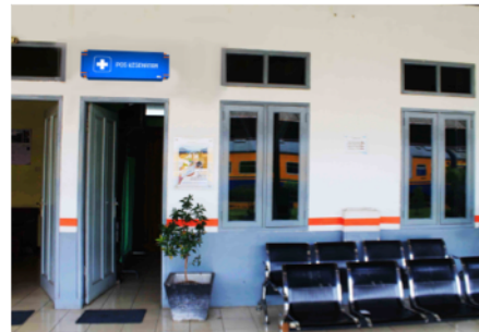
Gambar 1.15 Penerapan indoor sign system – Pos Kesehatan (Sumber : Dokumentasi pribadi)
