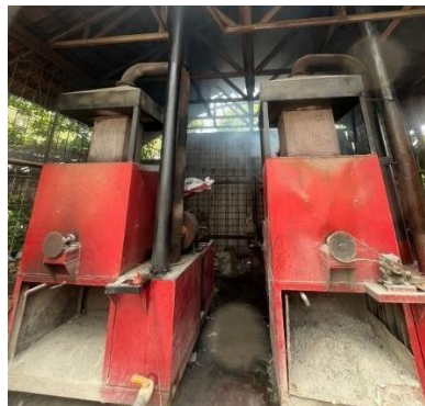
Gambar 1.4 Kawasan TPST insinerator.
