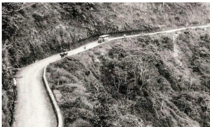
Gambar 1. Jalan Cadas Pangeran tahun 1910
