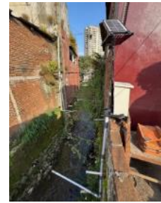
GAMBAR 1 (A) Lokasi Pemasangan Alat
