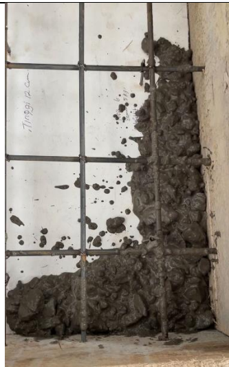
“Proses pengecoran di cetakan”
