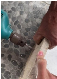
"Proses pelubangan untuk besi beton 6 mm"
