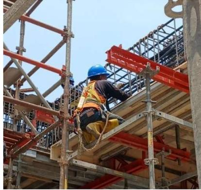
Gambar I-4 Proses Pemasangan Rebar dalam pembangunan proyek BDx *Data Center*
