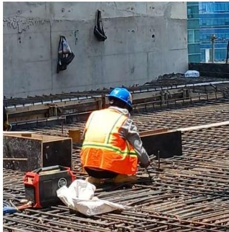
Gambar I-3 Proses Pengelasan Rebar dalam pembangunan proyek *BDx Data Center*
