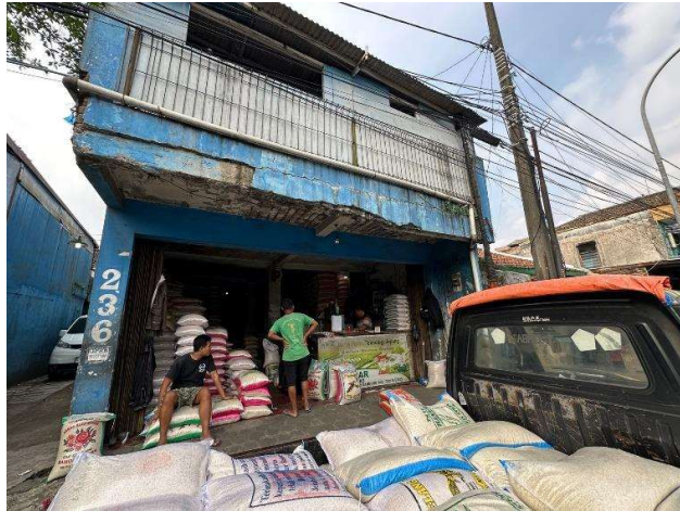
Gambar I.5 Kondisi Eksisting PD Jembar
