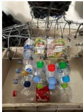
Gambar 11. Botol plastik yang sudah di tumpuk dan direkatkan ke kerangka Sumber: Penulis, 2024
