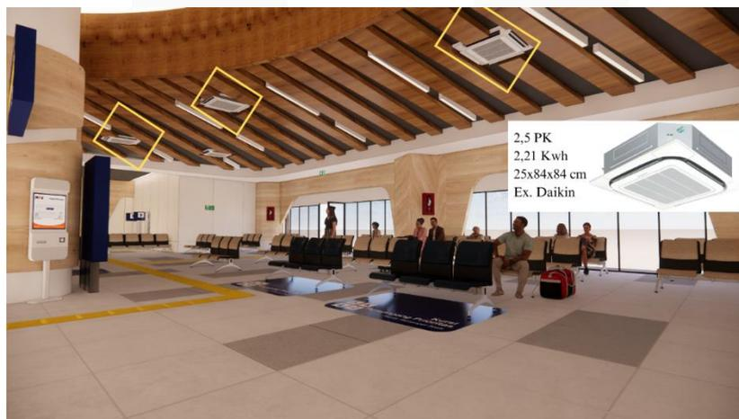
Gambar 7 Implementasi ventilasi mekanis pada ruang tunggu
