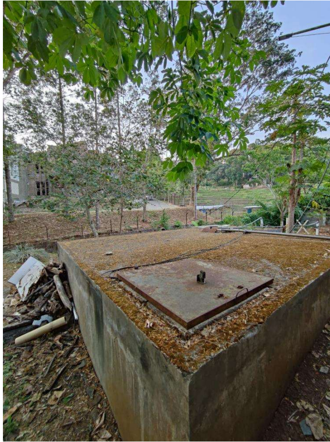
Gambar 1.1. Reservoir bawah kapasitas 40 m 3
