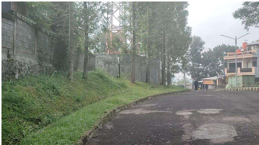
Gambar 1.2. Reservoir atas kapasitas 100 m 3
