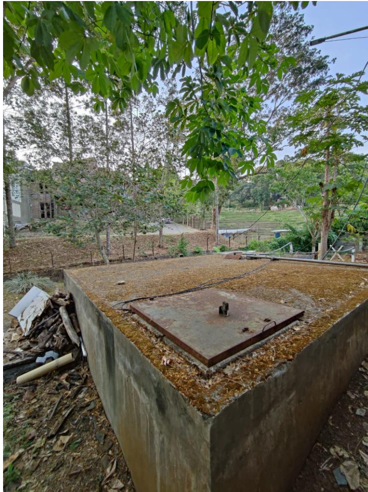
Gambar 1.1. Reservoir bawah kapasitas 40 m 3
