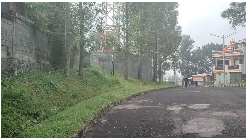
Gambar 1.2. Reservoir atas kapasitas 100 m 3
