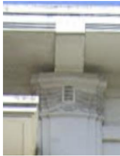
Gambar 5. Kolom Bangunan di Braga
