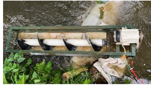
GAMBAR 3. Pengujian Turbin dan Generator
