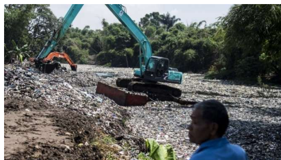
Gambar 1.2 Proses Pembersihan Sampah di Sungai dengan Eskavator
