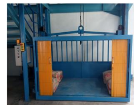
GAMBAR 2 - 2. Contoh lift barang pada konstruksi bangunan
