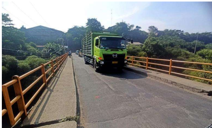
Gambar I. 1 Kondisi Jembatan Nanjung. Diambil dari (Yusuf,2022)
