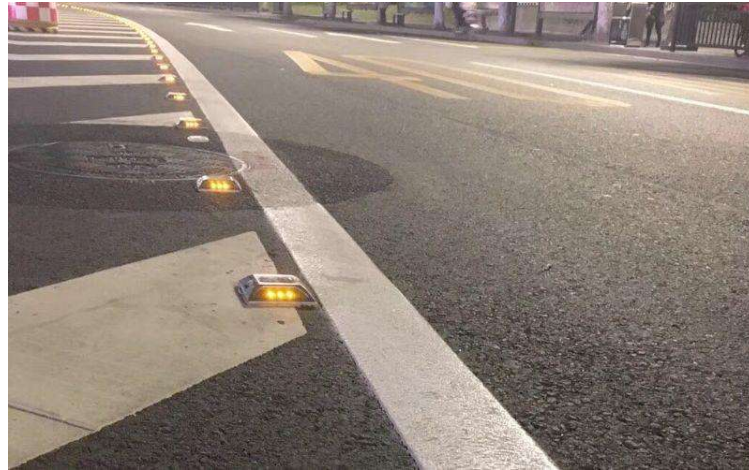
Gambar I. 3 Pemasangan Road Stud di Jalan. Diambil dari (Samwil,2021)
