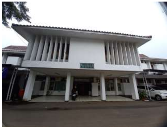
Gambar 1. 2 Kantor Diskominfo Kabupaten Karawang
