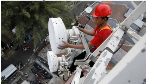
GAMBAR 2.2 (Physical Tuning pada antenna)
