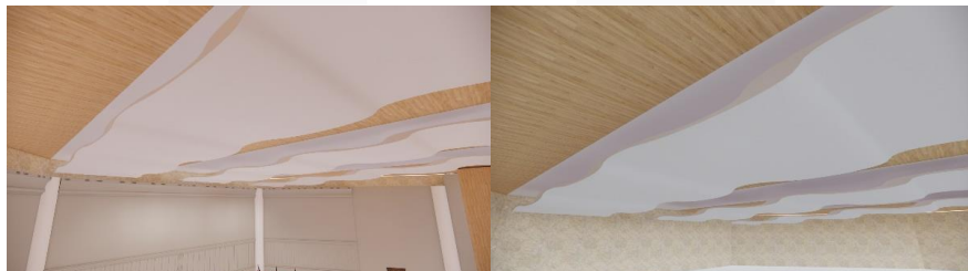
Gambar 4 Ceiling Accoustic Sumber: Data pribadi
