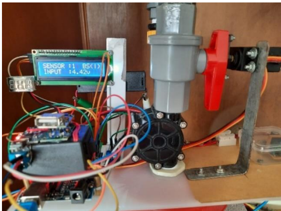
Gambar 11 Pengujian Brake Control Terbuka
