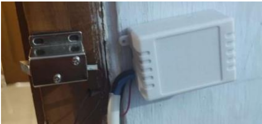
Gambar 4. 31 Pemasangan Door Lock
