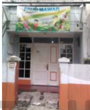
Gambar 1.1 Gedung PAUD Mawar
