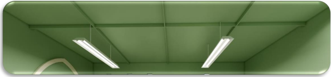
Gambar 52. Plafond Lambersering ruang kelas
