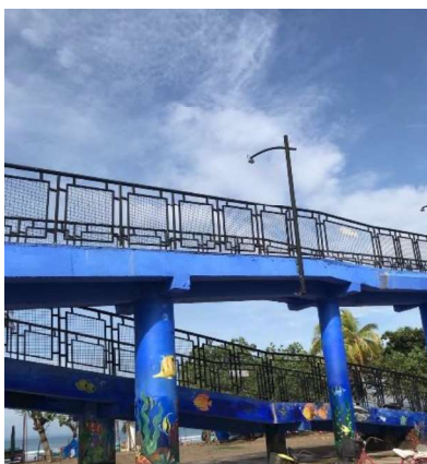
Gambar I. 3 Fasilitas Jembatan Pantai Pangandaran
