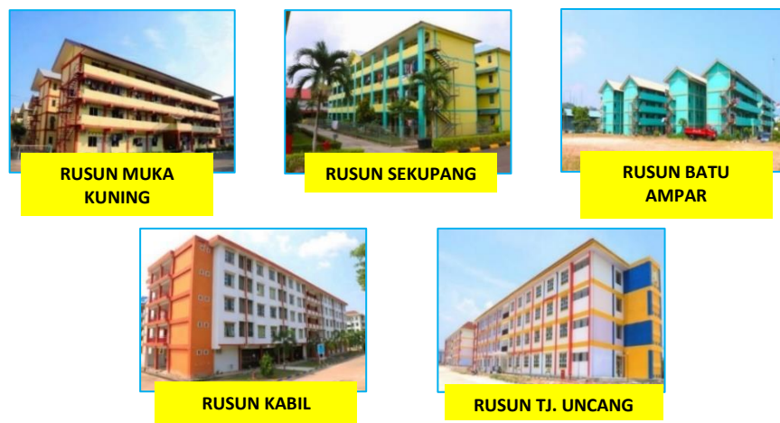
Gambar 1. 3 Rumah Susun BP Batam
