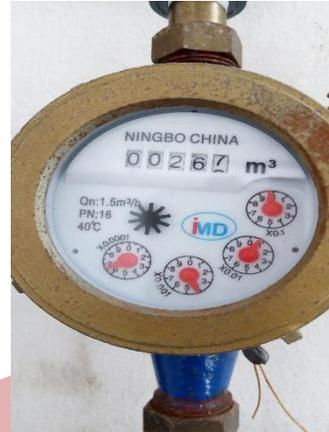
Gambar 2.1.3 Meteran air yang digunakan bertipe Nutatting Disc Meter
