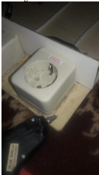
Gambar 4.4 Pemasangan Stop Kontak
