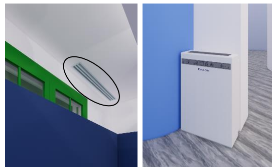
Gambar 3. 5 Penerapan AC Ducted Split dan Dehumidifier (Sumber: Dokumentasi Pribadi)
