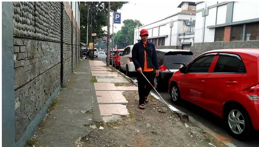
Gambar 1.1 Trotoar yang rusak
