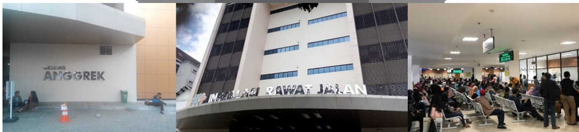
Gambar 3.2 Kondisi Gedung Angrek RSHS
