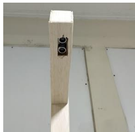
Gambar 3. Sensor Ultrasonik Terletak pada Bagian Atas Tiang.
