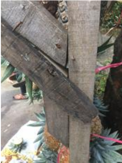
Gambar 3.2 Sistem joint yang digunakan (Sumber: Dokumentasi Penulis, 2018)
