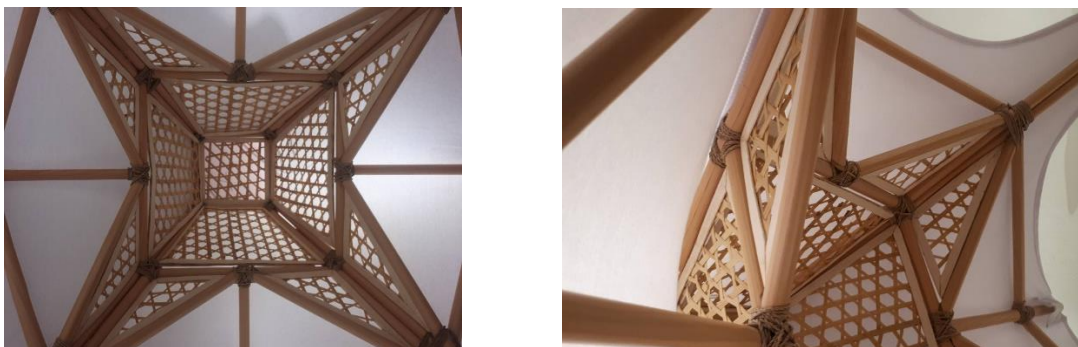
Gambar 3 Penerapan Material Membran dan Anyaman Bambu Tali pada Bagian Atap (Sumber: Dokumentasi Penulis, 2018)
