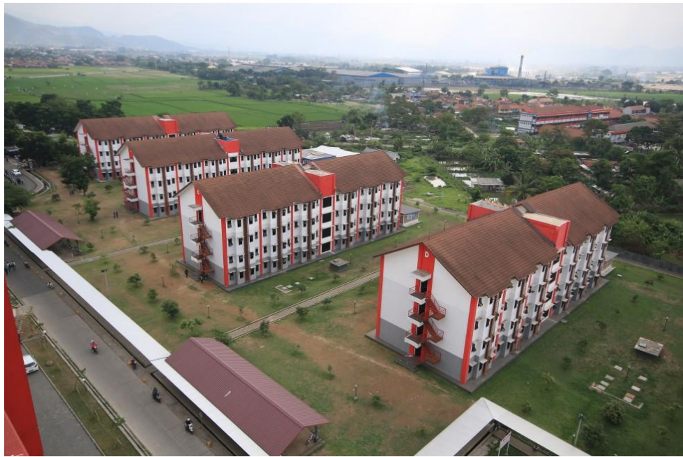
Gambar 1.1 Gedung Asrama Universitas Telkom
