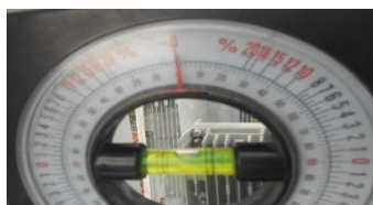
Gambar 4.3 Mekanikal Tilting Pada Site MARGAHURIP (Before)
