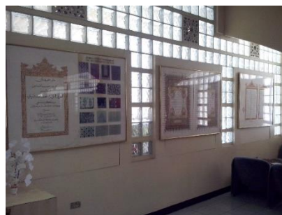
Gambar 3.10 Dinding glassbloks PUSDAI (Sumber: Dokumentasi pribadi, 2016)
