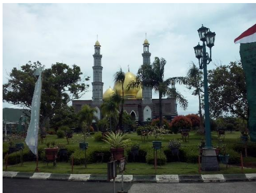
Gb 2.28 Fasad Masjid Dian Al-Mahri (Sumber: Dokumentasi pribadi,2016)
