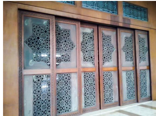
Gb 2.49 Pintu lipat masjid JIC (Sumber: Dokumentasi pribadi,2016)
