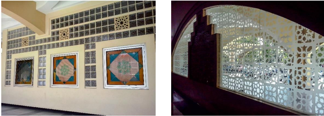
Gb.2.24 Pencahayaan dan penghawaan pada PUSDAI (Sumber: Dokumentasi pribadi,2015)
