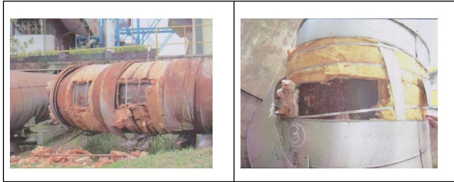
Gambar I.3 Korosi Pada Pipa Alir Uap Utama Unit 1
