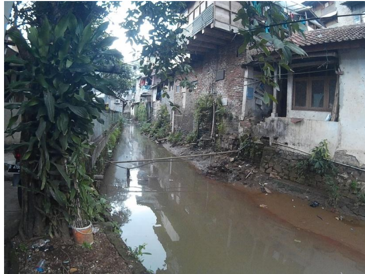
Gambar 2.10. Pembangunan Rumah Berdekatan Dengan Sungai
