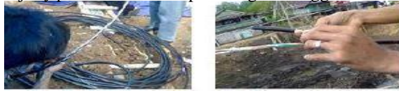
Gambar 4.2 Pengelupasan Kabel Serat Optik
