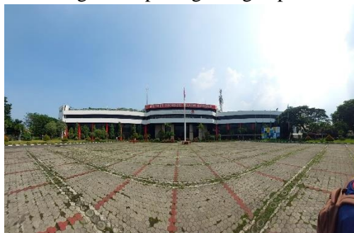
Gambar 2 Tampilan Gedung Kampus Institut Teknologi Telkom Surabaya
